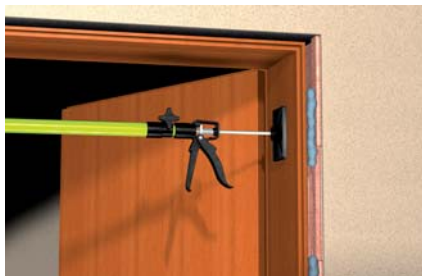
Foaming door frames
