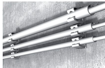
Fixação de conduítes isolantes de plástico
