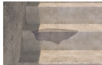
Reconstrução de cantos e arestas.
