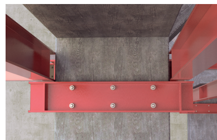
Fixação de estruturas metálicas.
