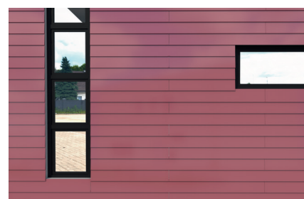
Subestruturas de fachada
