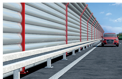
Barreiras de isolamento de trânsito
