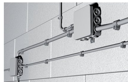
Fixação de cabos
