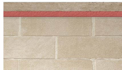
Aplicação de juntas na construção
