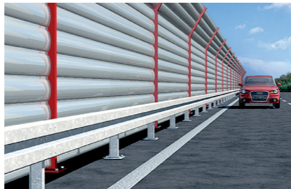
Barreiras de isolamento de trânsito
