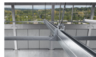
Grade de instalação: perfil FUS D, FVS 41 II, FUH
