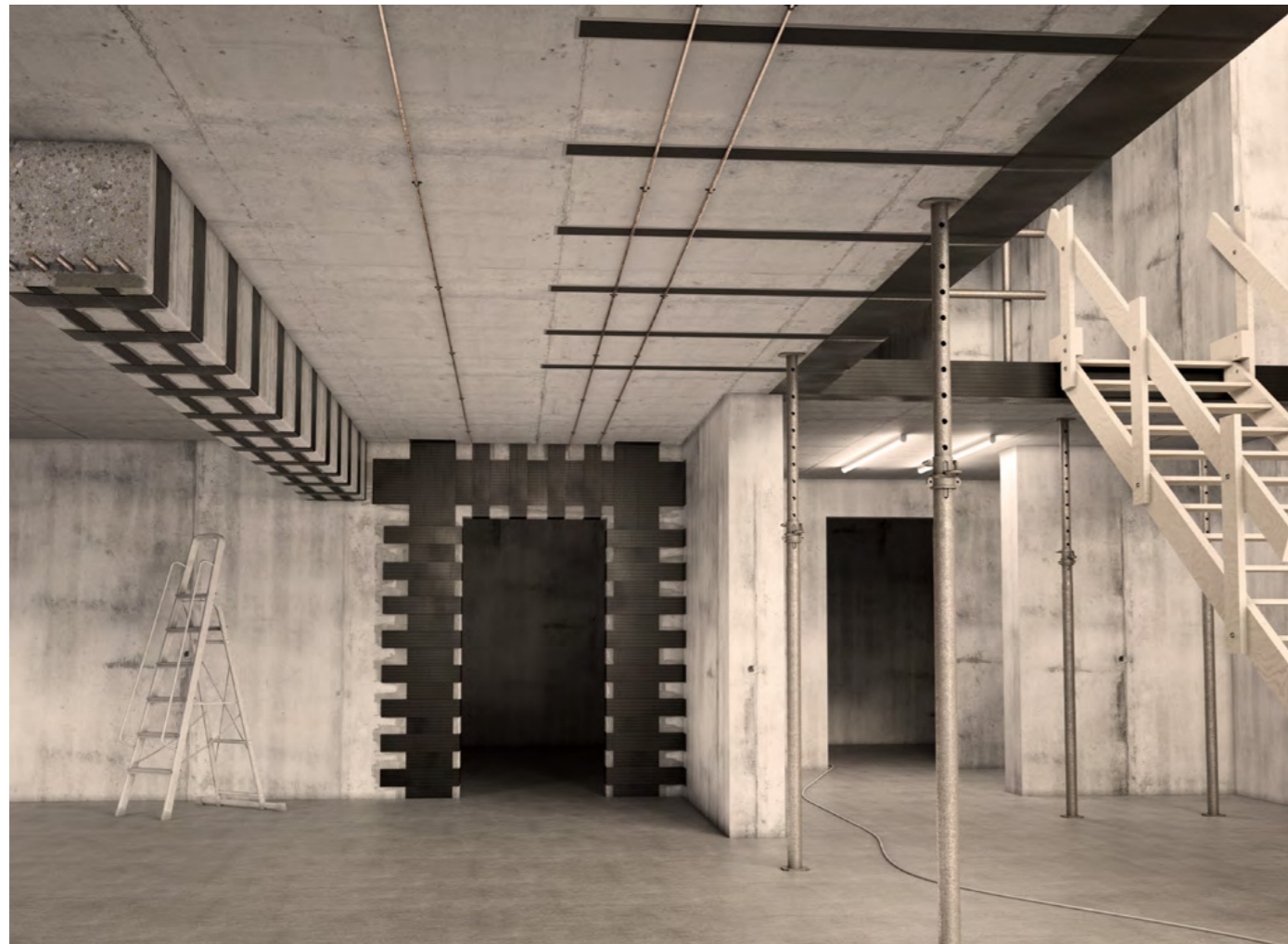
Edificação com reforço à flexão e ao cisalhamento.
