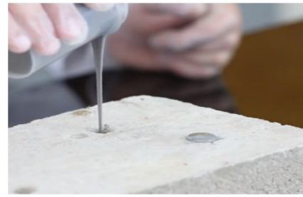
Colagem em concreto.
