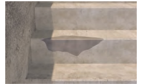
Reconstrução de cantos e arestas.
