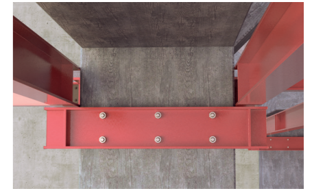
Fixação de estruturas metálicas.
