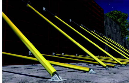
Suportes inclinados ou fixações temporárias
