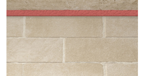
Aplicação de juntas na construção
