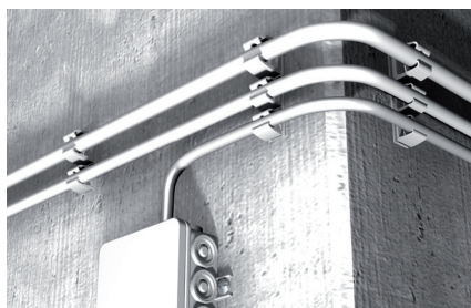
Fixação de cabos elétricos
