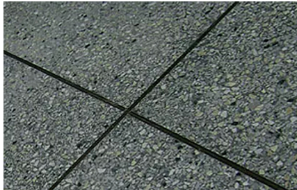
Juntas de movimentação no piso
