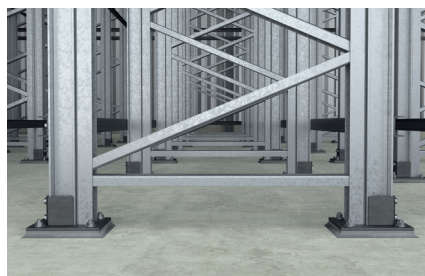
Fixação de estruturas metálicas
