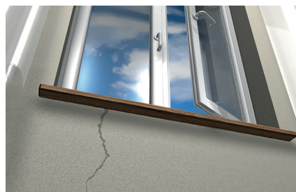
Reparo de fissuras
