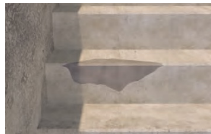
Reconstrução de cantos e arestas.
