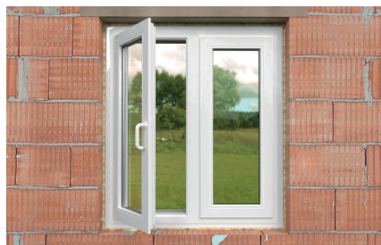
Preenchimento de vãos de portas e janelas
