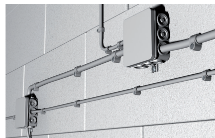
Fixação de cabos
