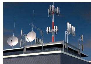
Antenas e mastros
