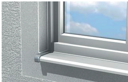
Colagem e vedação de acessórios
