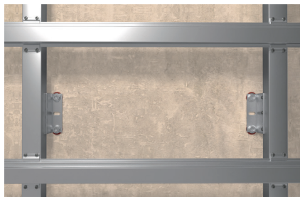
Subestruturas de metal
