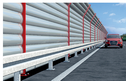
Barreiras de isolamento de trânsito
